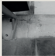
Betonanierung/Profilvergussung
